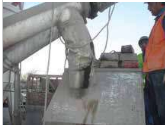
VERIFICACIÓN BÁSCULAS DE CEMENTO Y ADICIONES
