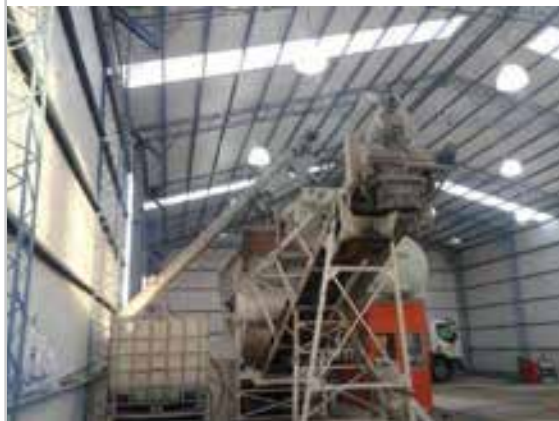
VERIFICACIÓN DE APTITUD DE PLANTAS HORMIGONERAS SEGÚN IRAM 1666
